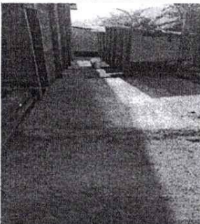
Foto 5: Entortado area de los baños
